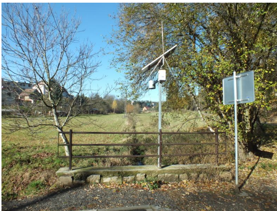
Profil je vybaven ultrazvukovým detektorem výšky hladiny s dálkovým přenosem dat
